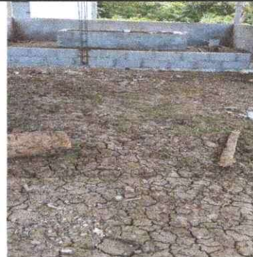
Foto 4: COCINA: Se logra apreciar el estado en que se encuentra el piso de la cocina de la escuela.
